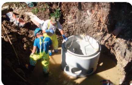
Pose d'une chambre préfabriquée dans le ruisseau de Chaluet pour les eaux usées
