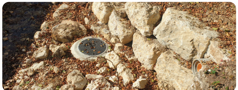
Nouvelle chambre étanche pour les eaux usées
