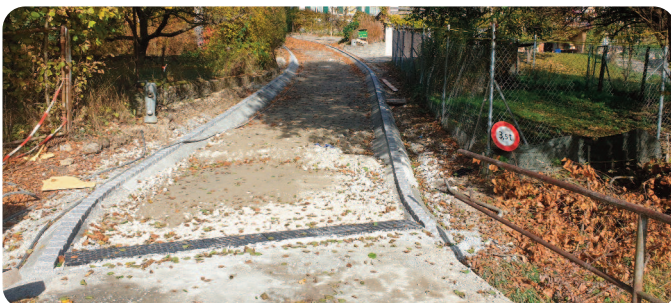
Pose de nouvelles bordures avant la première couche de bitume
