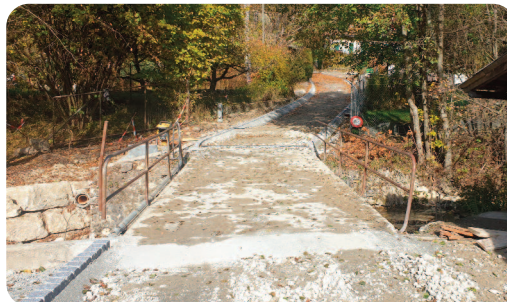
Le pont surplombant le ruisseau de Chaluet sera assaini.
