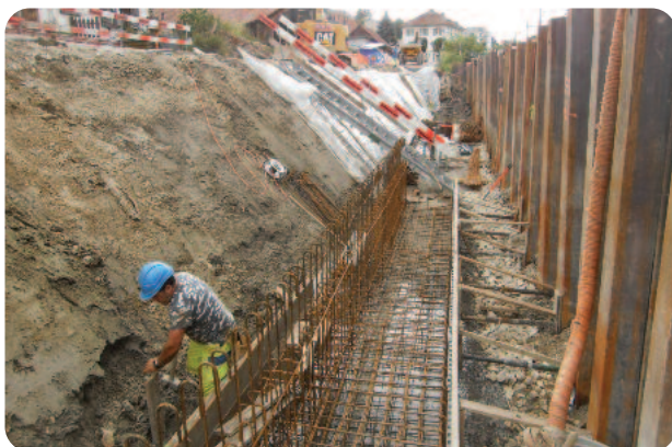
Début du bétonnage du mur au long de la Birse.
