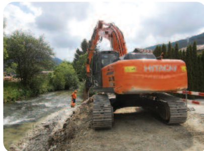
Pose des palplanches dans la Birse en juin 2016.
