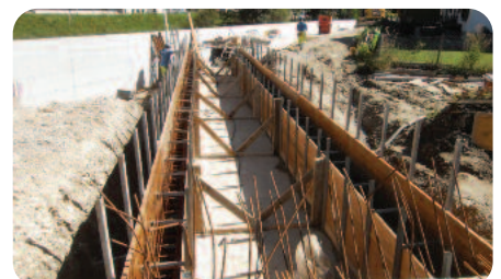
Ferrailage du canal.
