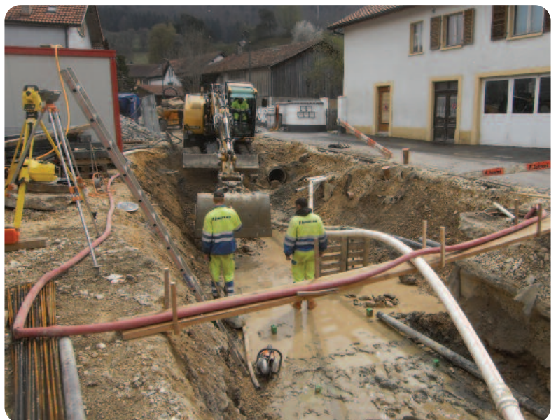
Avril 2017 : début des travaux à la Rue de la Valle.
