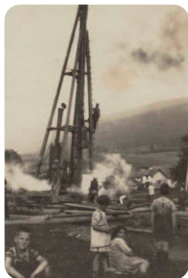
Construction de la halle de gymnastique sur pilotis dans les années 30!
