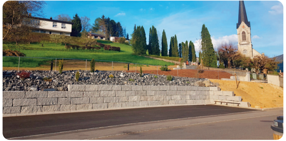
Aménagement de 20 places de stationnement, dont une réservée aux handicapés.
