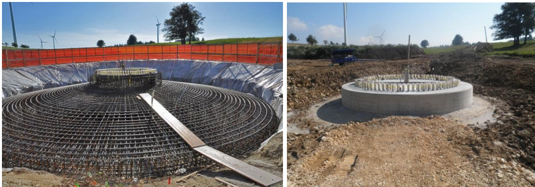
Figure 28: illustration de la création d'un socle durant la phase de chantier (Source des images: JUVENT SA).
