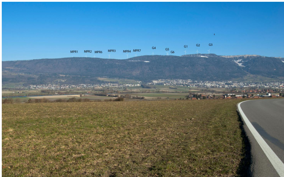
Figure 62 : Photomontage 27, pris au sud de Rüti bei Büren montrant de quelle façon les parcs éoliens seront visibles depuis la plaine de l'Aare. Les éoliennes sont lointaines et pas au même plan que le tissu bâti.
