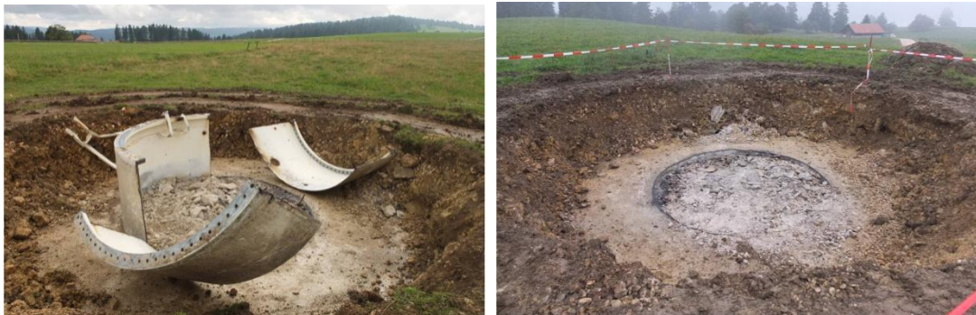
Figure 30: vue sur différentes étapes de remise en état du site après le démontage des anciennes éoliennes à l'exemple du site de Juvent. L'image de droite montre la zone sur laquelle un sol sera remis en place et remis en culture (Source des images: JUVENT SA).
