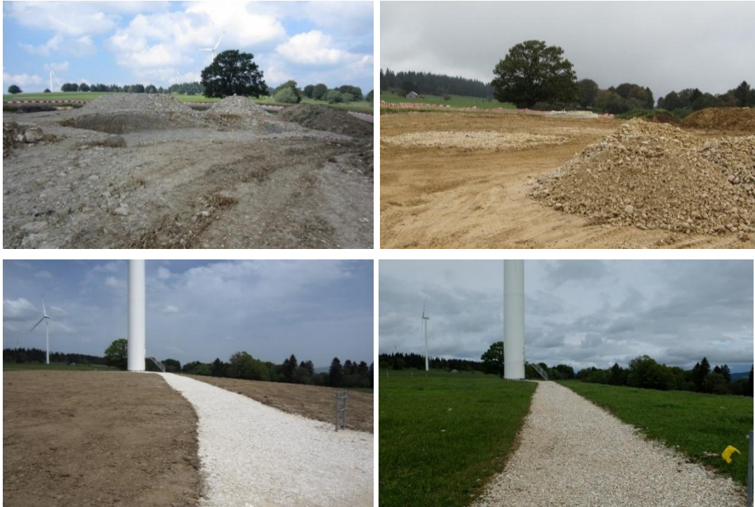
Figure 27: quatre vues sur une place de montage durant et après la phase de chantier dans le parc éolien de Juvent (Source des images: JUVENT SA).
