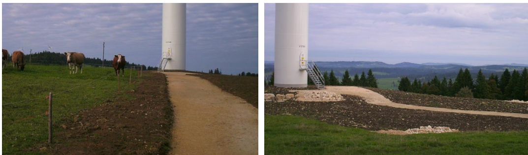
Figure 29 : exemples de remise en état avant l'ensemencement des surfaces. Le bétail ne doit pas avoir accès aux surfaces restituées lors de la première, voire de la deuxième année suivant la restitution (Source des images: JUVENT SA).
